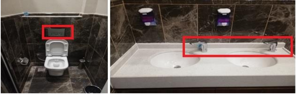
Şekil 19. Sensörlü musluklar ve az-çok opsiyonu bulunan tuvalet sifonları
