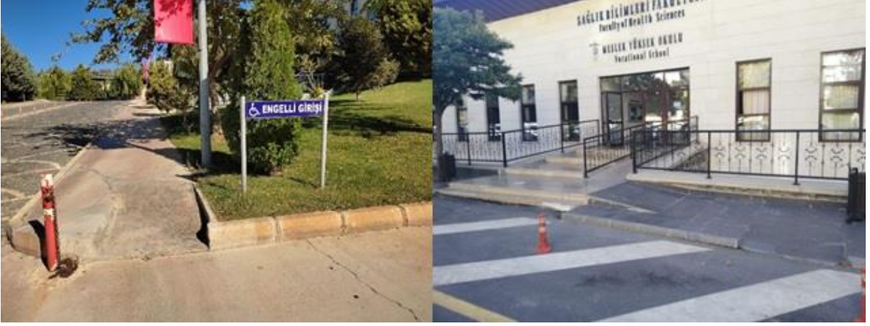
Şekil 25. Engelli girişi ve tabelası (solda) ve bina girişinde yer alan engelli rampası (sağda)
